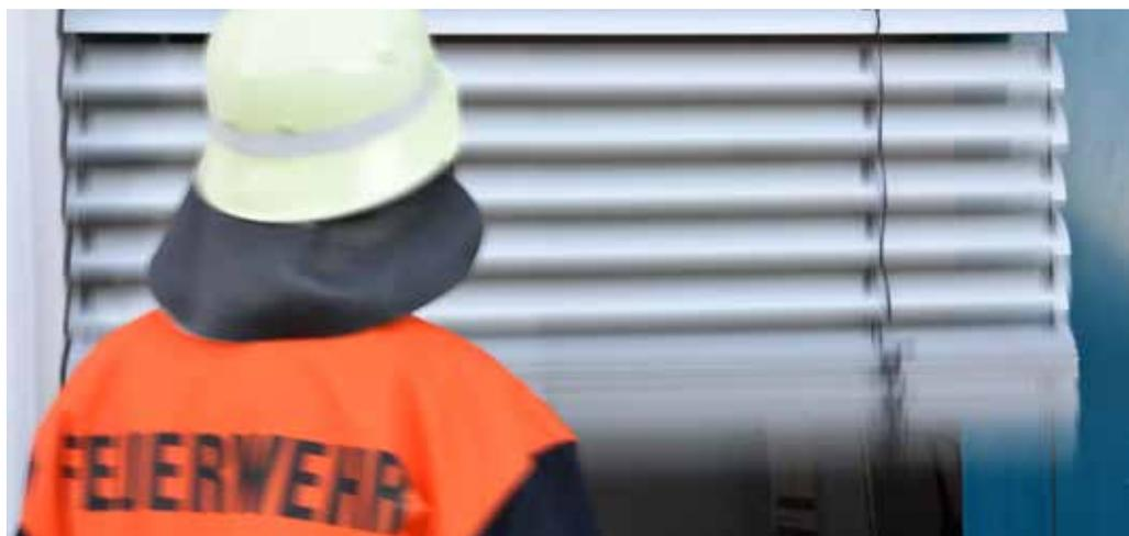
Der mechanische Not-Raffstore EL 80N NRS wird bei Betätigung des Auslösehebels über eine vorgespannte Feder hochgezogen.
